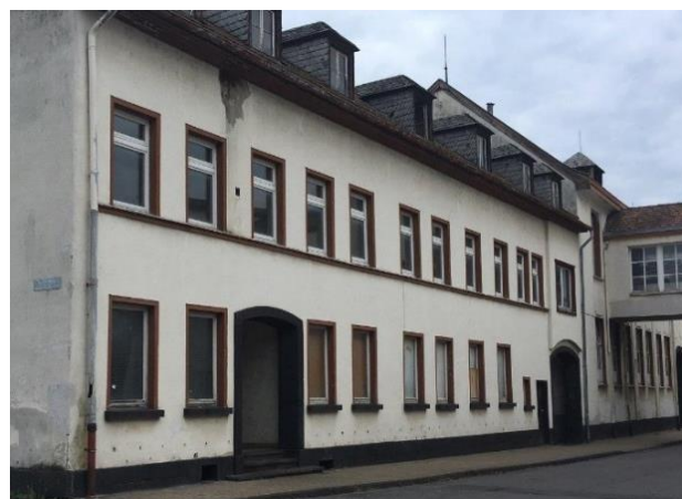
Ehemaliges Bürogebäude der Hilgers-Werft.
